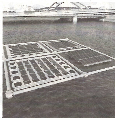
洋上浮体式太陽光発電施設
