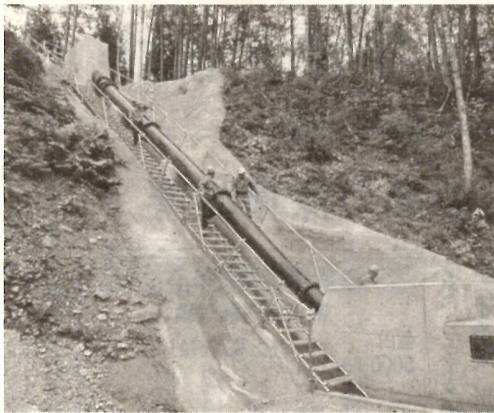
大和ハウスは各地に水力や地熱発電所をつくる(東芝が設備を納入した水力発電所の例)
